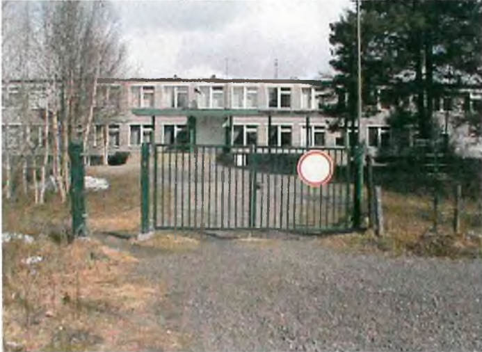
Фото № 1: Центральный вход на территорию объекта.
